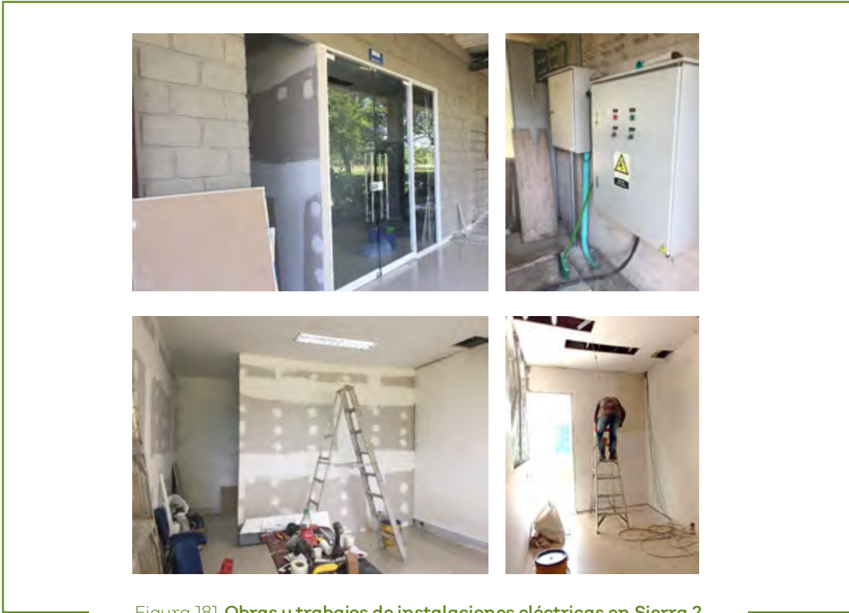
Figura 181. Obras y trabajos de instalaciones eléctricas en Sierra 2
