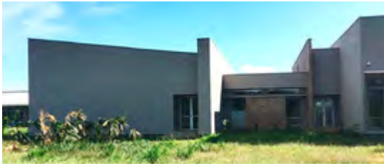
Figura 164. Fachada posterior del módulo de laboratorios CEPC
