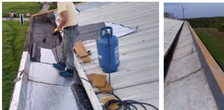
Figura 178. Mantenimiento de vigas, canales y cubiertas
